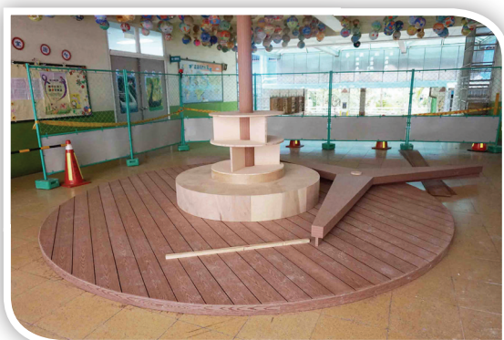
圖書室入口意象的施工情形。
