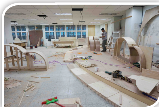
圖書室內部的施工情形。
