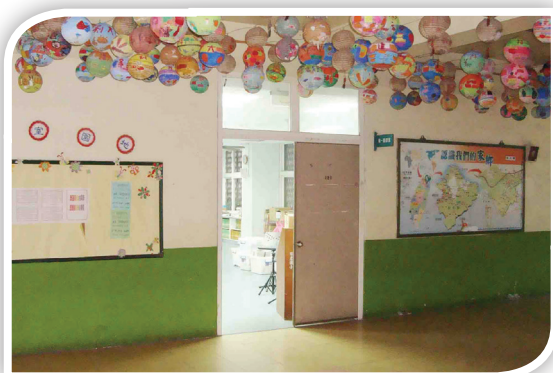
圖書室施工前的入口意象。
